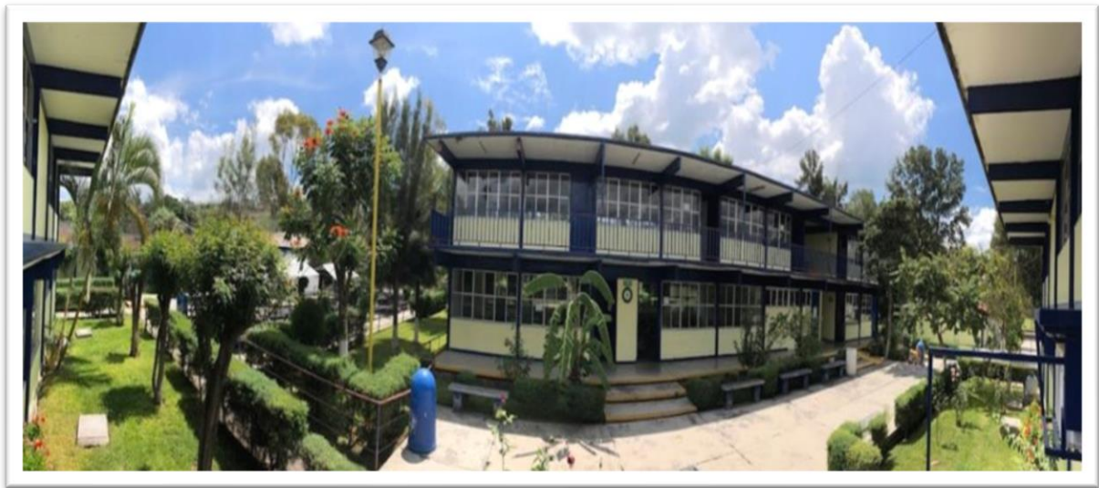
CETis 160 Jaral del Progreso, estado de Guanajuato.
